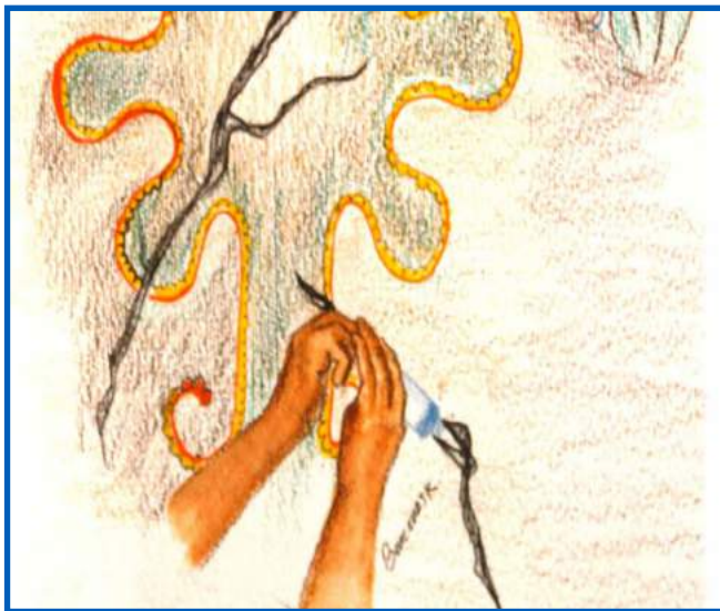
Inyección de grietas
